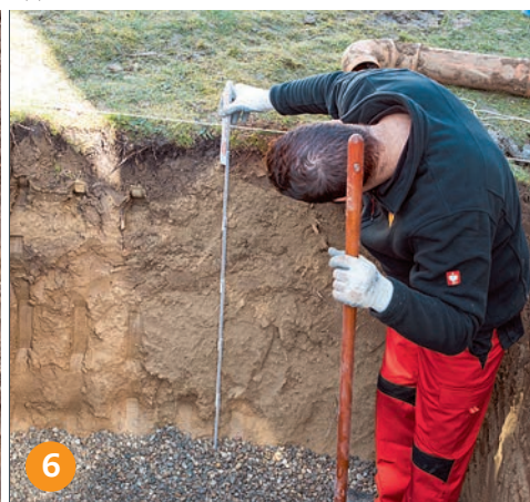
6 Основание должно быть на глубине равной высоте емкости с крышкой, или немного ниже.
