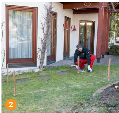
2 С помощью колышков и шнура, разметить место для котлована.
