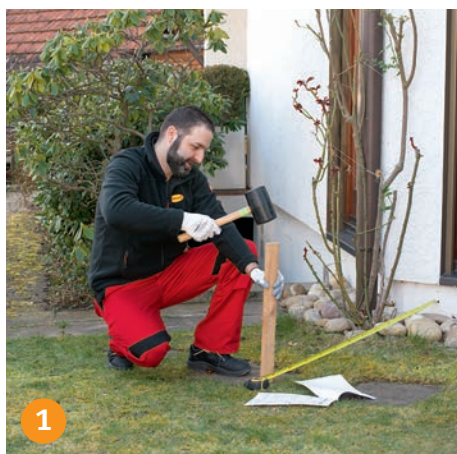
1 Соблюдайте расстояние от фундамента согласно инструкции
