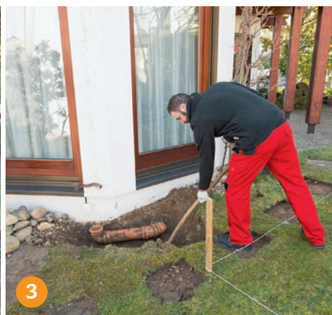
3 Подготовить траншею для трубы. Уклон трубы слива в резервуар должен составлять 1%.
