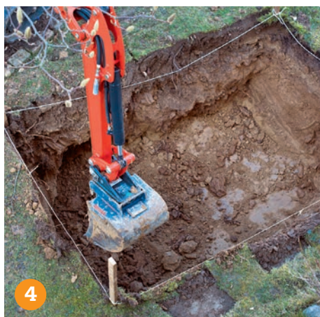
4 Экскаватором или вручную выкопать котлован на 10см больше размеров емкости и на 15см глубже высоты емкости
