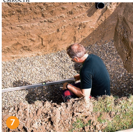
7 С помощью уровня проверяем горизонтальность основания, при необходимости - подровнять.
